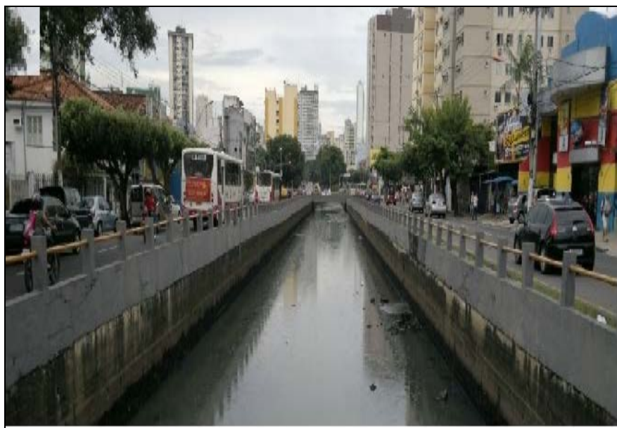
Figura 2 – Canal da Tamandaré
